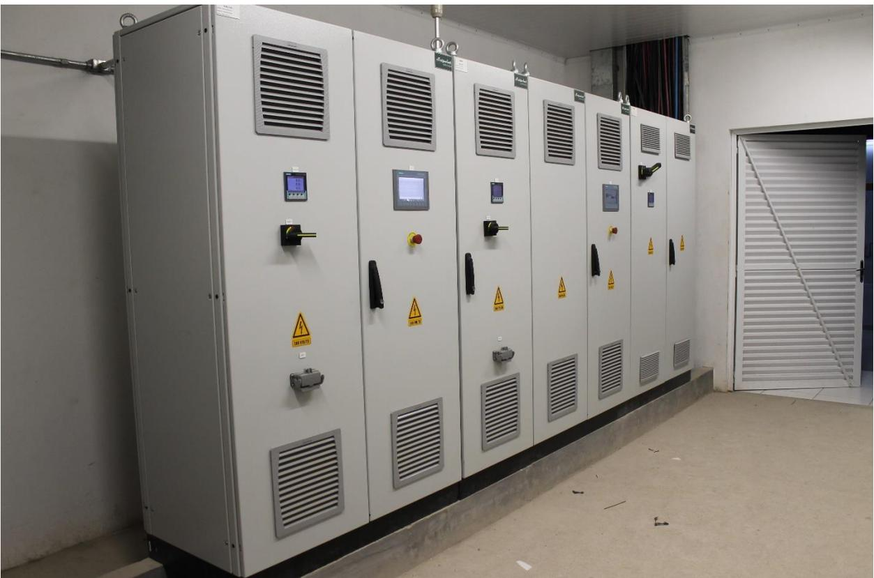
Central CIP – sistema para acionamentos das bombas de recalque, recirculação e controle (CCM / CLP Central)
