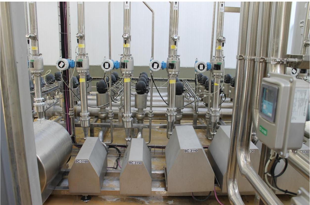
Central CIP – manifold de recalque de água e soluções químicas
